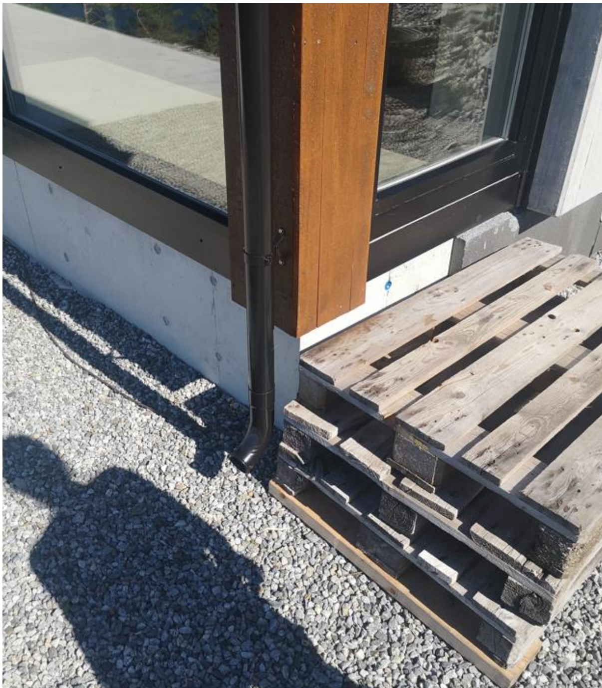
Figur 2. Overvannsløsning ved eksisterende hyttefelt, øst for felt 1. Takvannet slippes ut på drenerende masser.
