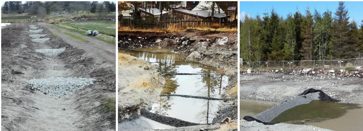
Figur 10. Eksempler på enkle erosjonsdempende tiltak med pukk og grus i grøft og dam.
